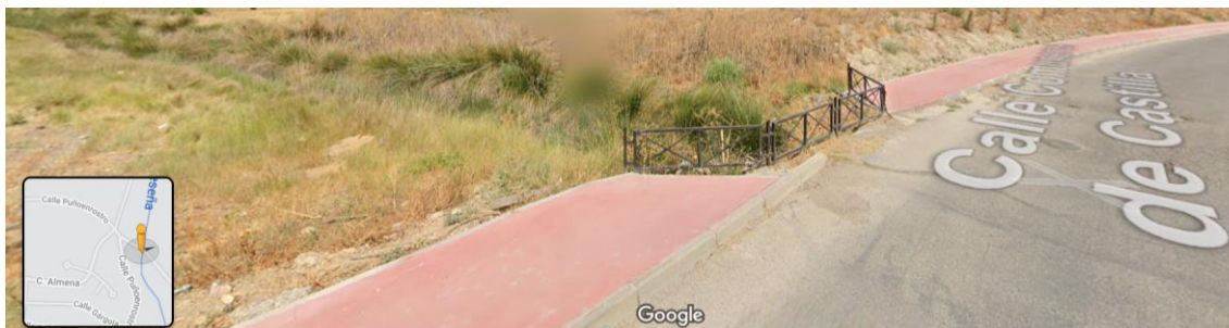
Estado del Arroyo en el límite norte de la zona habitada de Seseña
